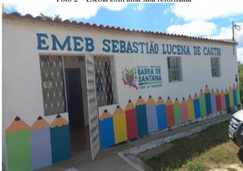
Foto 2 – Escola com uma sala reformada
