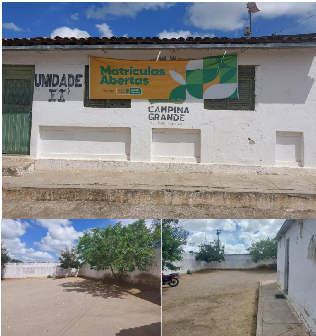
Figura 3 – Unidade escolar - Anexo
