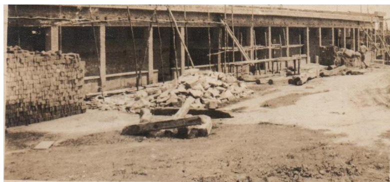
Fotografia 9 – Construção do prédio do Carlota Barreira: vista frontal
